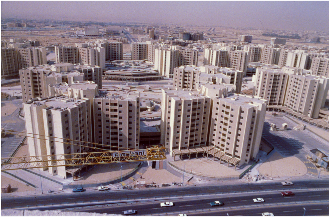
리아드 주택단지 건축 공사, 시공 BS한양, 사진 제공: 국가기록원
